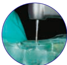
Foratura per consentire l'iniezione del composito
